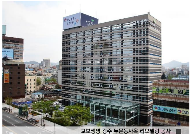
교보생명 광주 누문동사옥 리모델링 공사
