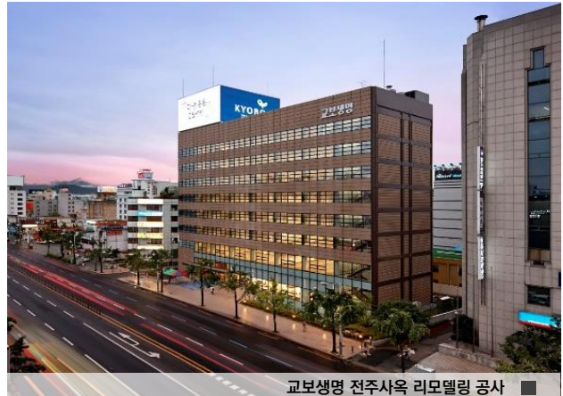
교보생명 전주사옥 리모델링 공사
